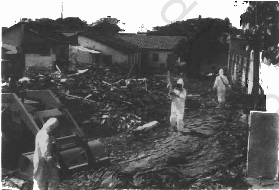
لوحة (٩ - ٢) عملية إزالة أنقاض أحد البيوت التي هدمت نتيجة تلوثها بالمادة المشعة .
