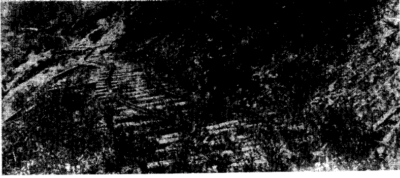
(زحف والتواء خطوط السكك الحديدية بعد الزلزال)
