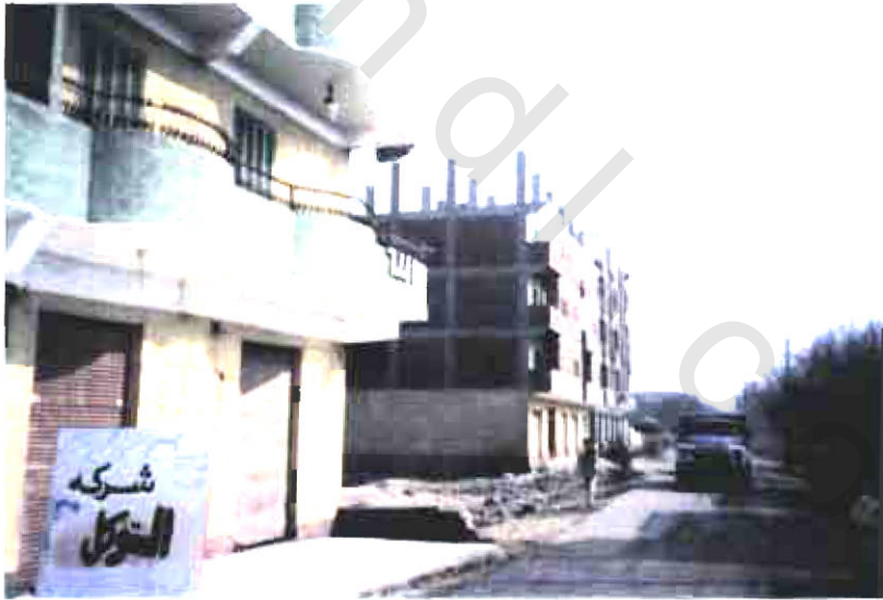
الامتدادات العمرانية الجديدة بالقرية ذات الطابع الحضري ( لاحظ الاعمدة الخرسانية فوق الاسطح للامتداد الراسى المستقبلى للمبنى ) شكل رقم (٣-٤)
