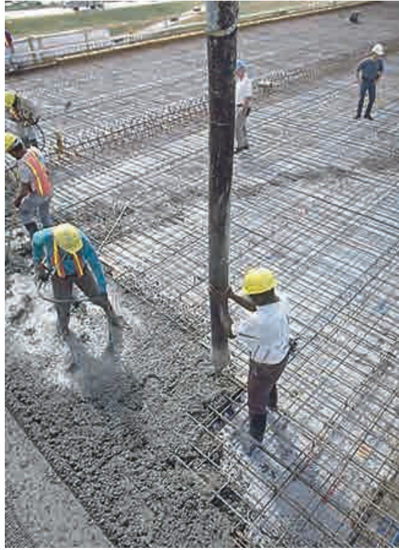
الشكل 9-26 يصب الأسمنت حول قضبان الفولاذ لعمل خط سير سريع.
