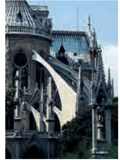
الشكل 9-30 أكتاف هوائية (طيارة) في كاتدرائية نوتردام، في باريس.
