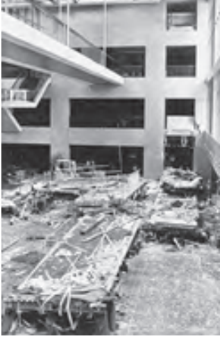
الشكل 1-9 انهار ممر مشاة صاعد في فندق مدينة كنساس عام 1981. كيف كان لحسابات فيزيائية بسيطة إمكانية تجنب الضياع المأساوي لحياة أكثر من 100 فرد، سيناقش هذا في (المثال 9-12).
