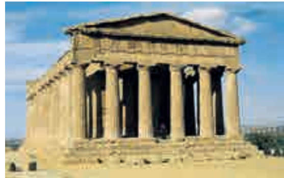
الشكل 9-21 هذا المعبد الإغريقي، في أغريغنتو، صقلية، بني قبل 2500 سنة، يبين بنية العمود والدعامة الأفقية. الأعمدة تقع تحت انضغاط.
