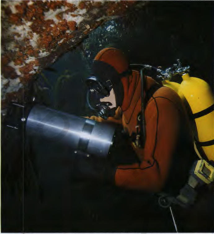
قد يرتدي الغطاسون البدلات الجافة من أجل بقاء أجسامهم دافئة تحت المياه الباردة فوجود طبقة من الهواء بين البدلة وجسم الغطاس يقلل من الفاقد الحراري.
