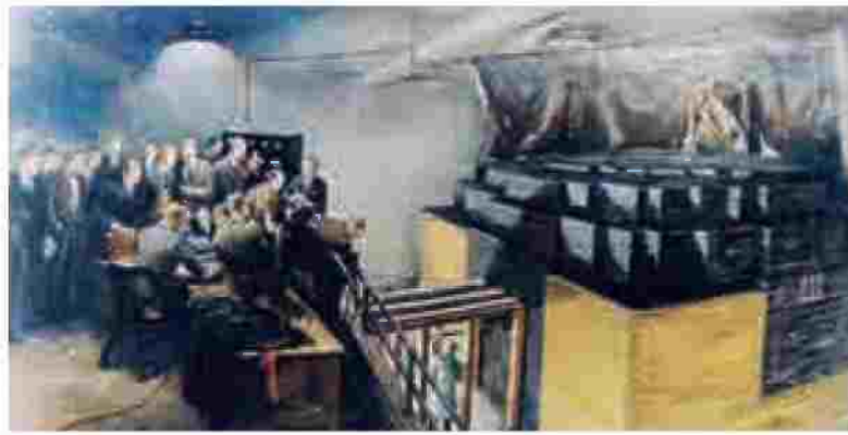
الشكل 31 - 5 رسم ملون لأول مفاعل نووي بناه فيرمي تحت المدرج المسقوف لحقل ستاج في جامعة شيكاغو (لا توجد صورة للمفاعل لأنه يعدّ سرّاً عسكرياً). استخدم اليورانيوم الطبيعي مع الجرافيت كمهدئ. في الثاني من كانون الأول عام 1942 سحب فيرمي قضبان التحكم المكونة من الكادميوم وبدأ المفاعل بالعمل. أول إثبات شخصي للتفاعل المستسلل بُلغ ل واشنطن بالهاتف من قِبَل آرثر كومبتون الذي شهد الحدث وسجل: (الربان الايطالي هبط الآن في العالم الجديد). جاري شيهان، (ولادة العصر الذري) شيكاغو (النيوز)، 1942.
