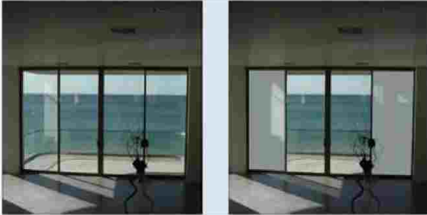
الشكل (124) صورة تبين تأثير التقنيات المتضمنة لحبيبات أو سوائل بلورية تتغير ألوانها كهربائياً على تبديل الشفافية إلى عتمة ضبابية في درفتي الزجاج الجانبيتين للجدار الزجاجي.
