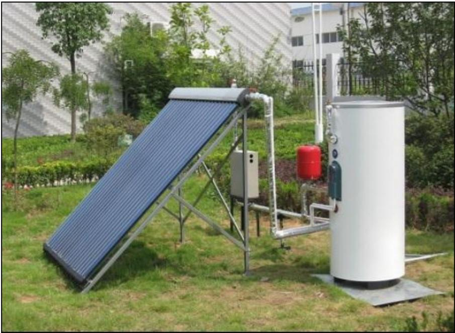
شكل (3-15): تسخين المياه بالطاقة الشمسية
