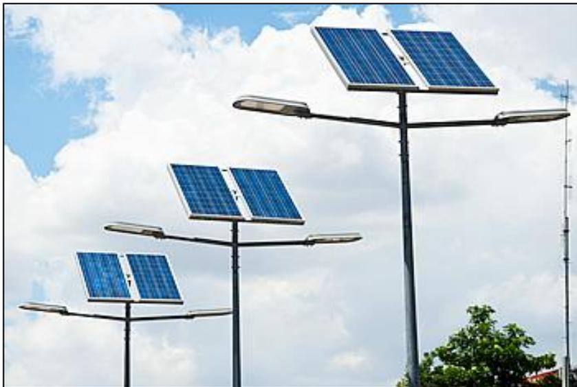
شكل (3-8): إضاءة الطرق بالطاقة الشمسية
