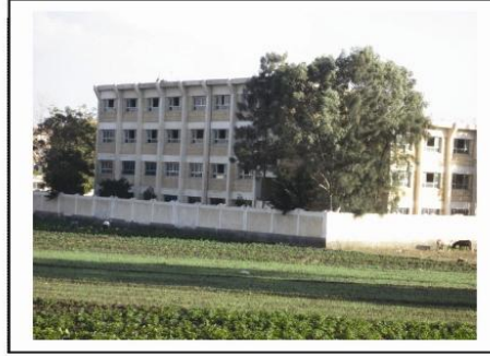
صورة (٢٠) أحد المنشآت التي قامت على أرض زراعية - مدرسة - وصدر لها ترخيص بناء، قرية قليشان (مركز إيتاي البارود) .
