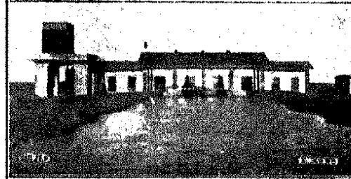
عمارة طلمبات البصري للصرف مشتملة على اربعة طلمبات عمود طرز سولزر ديزل منها عمود بواسطة محرك سولزر ديزل قوة ١٠٠ حصاناً
