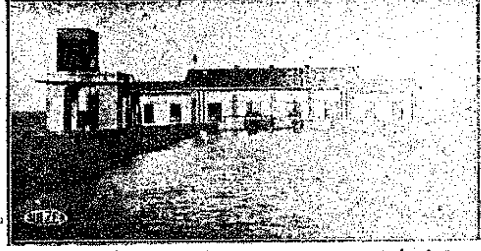
عملية طلبيات البصيني للصرف مشتملة على اربع طلبيات بمراوح طرز سولزر كل منها تدار بواسطة محرك سولزر ديزل قوة ١٤٠٠ حصانا
