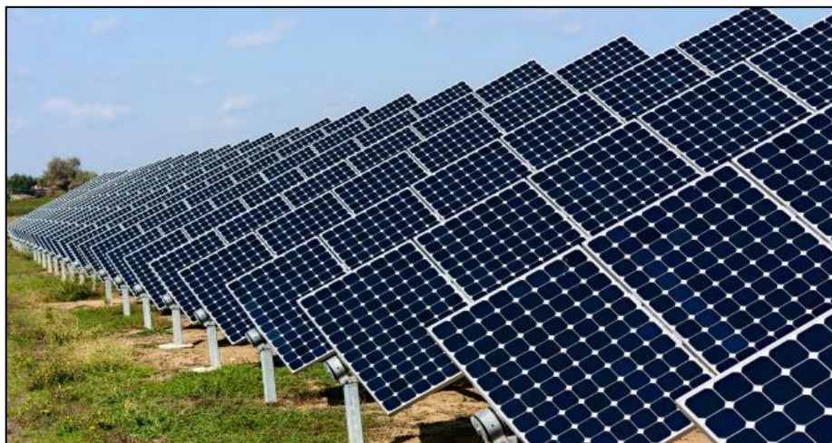
شكل (3-27): حقل خلايا كهروضوئية متحركة
