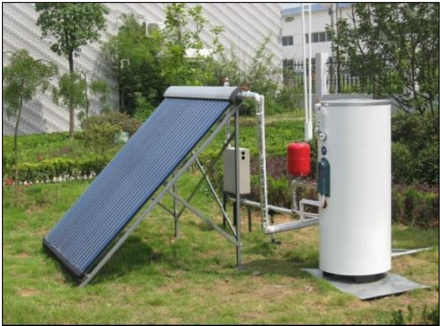
شكل (3-15): تسخين المياه بالطاقة الشمسية
