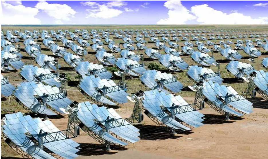
شكل (3-23): حقل مجمعات طبق القطع المكافئ
