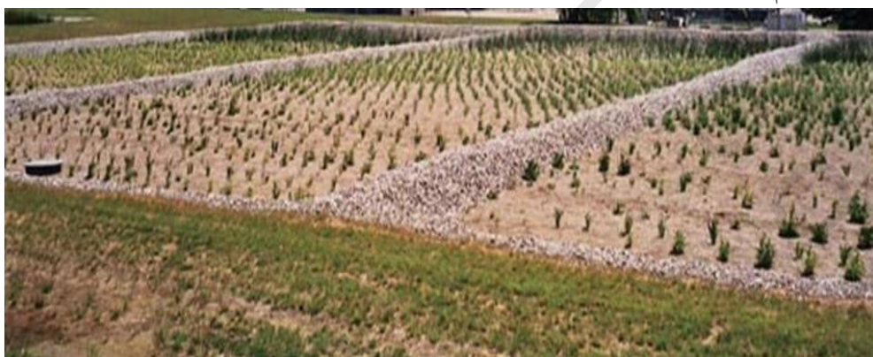
شكل (5-11): زراعة الأحواض بشتلات النباتات في نظام الانسياب تحت السطحي
