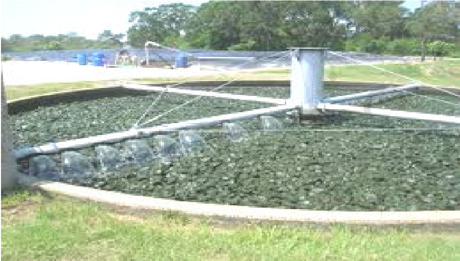
شكل (4-12): مرشح التقطر Trickling filter
