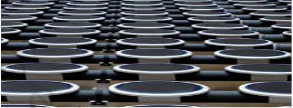
شكل (10-4): ناشرات هواء على شكل أقراص
