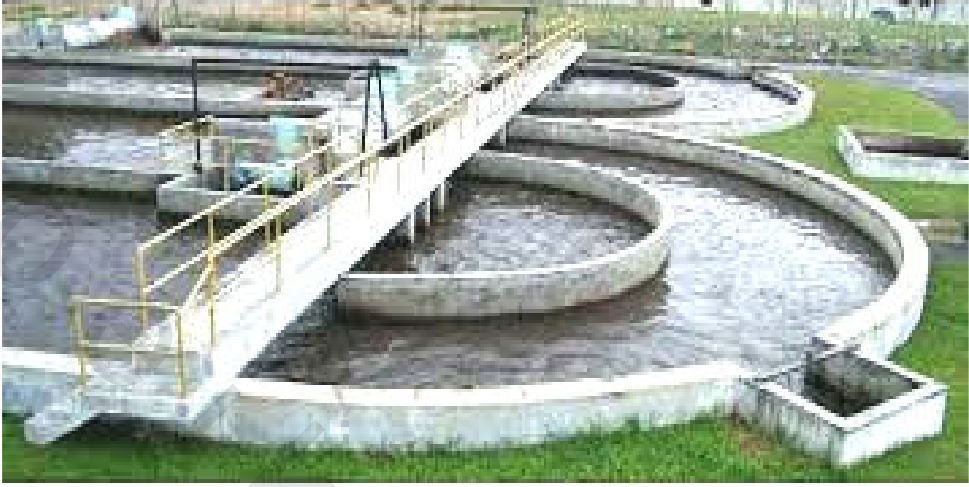
شكل (4-5): محطة حمة منشطة من النوع المسمى خندق الأكسدة
