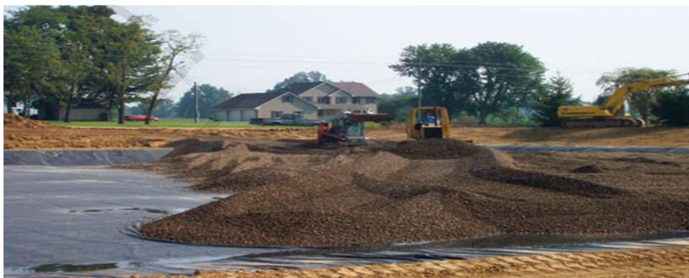
شكل (5-10): ملء حوض الزراعة بعد التبتين بالبلاستيك ببيئة النمو من الحصى
