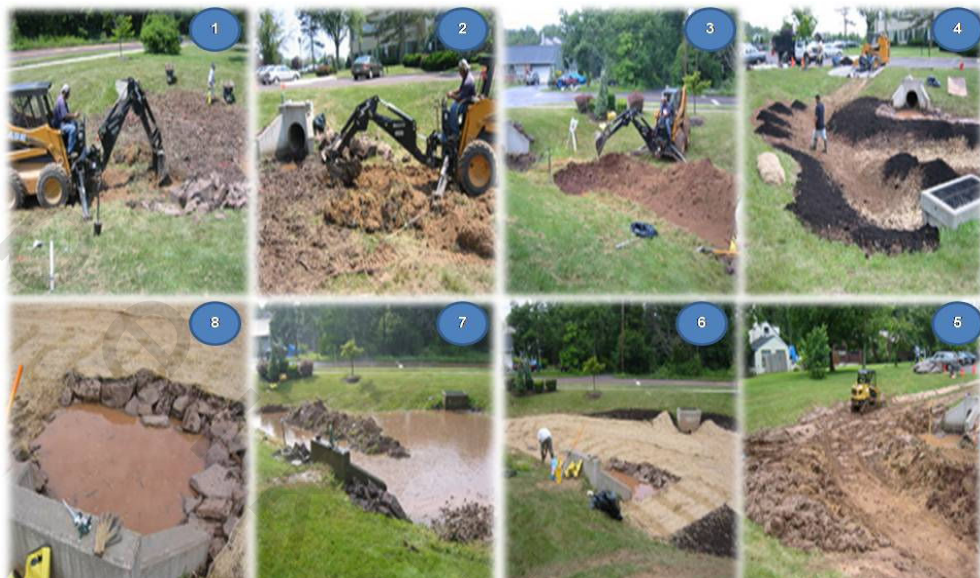
شكل (5-13): خطوات إعداد أحواض الزراعة في الأراضي الرطبة بدون تبطين
