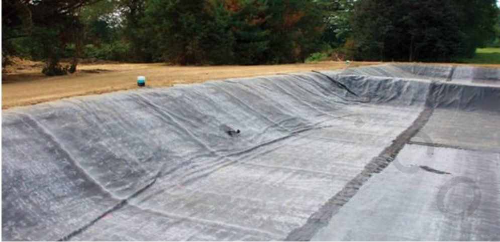
شكل (9-5): تبطين حوض الزراعة بالبلاستيك بعد حفرها ودكها
