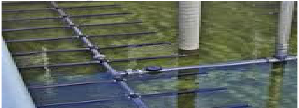
شكل (11-4): ناشرات هواء على شكل أنابيب
