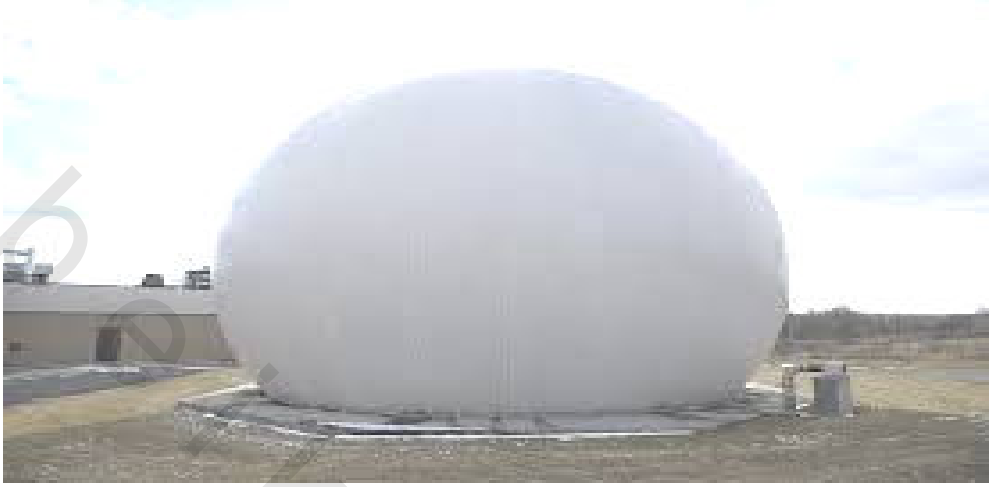
شكل (16-4): خزان خاص لتخزين الغاز الحيوي لحين استخدامه
