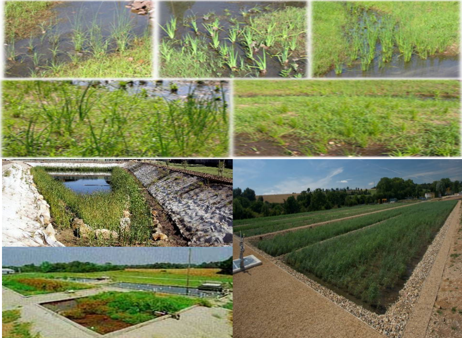
شكل (5-5): نماذج من وحدات الأراضي الرطبة التي يتم تشييدها هندسيًا على الأرض
