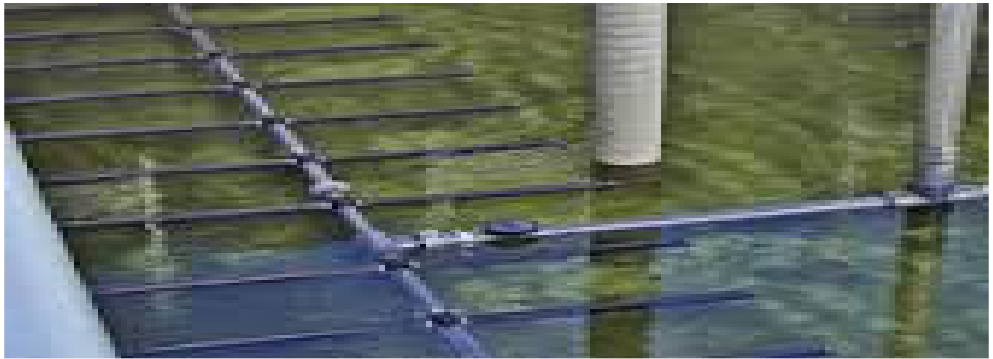
شكل (11-4): ناشرات هواء على شكل أنابيب
