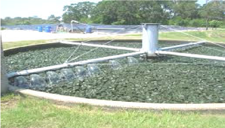
شكل (12-4): مرشح التقطر Trickling filter
