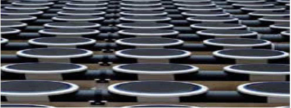
شكل (10-4): ناشرات هواء على شكل أقراص
