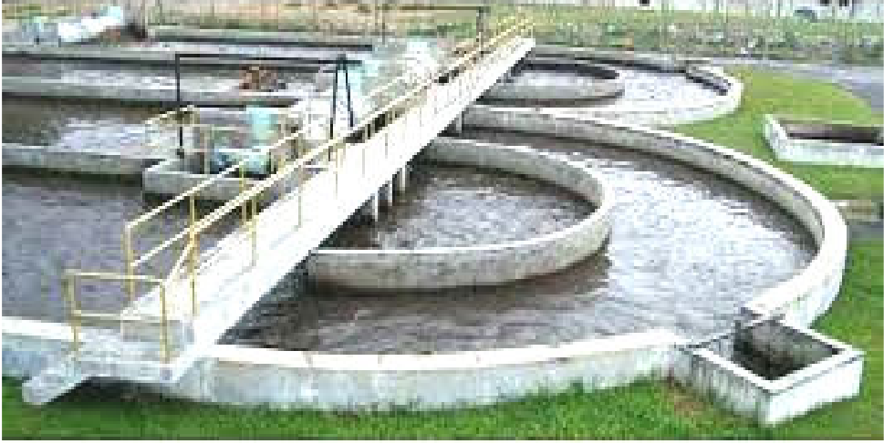
شكل (4-5): محطة حمأة منشطة من النوع المسمى خندق الأكسدة
