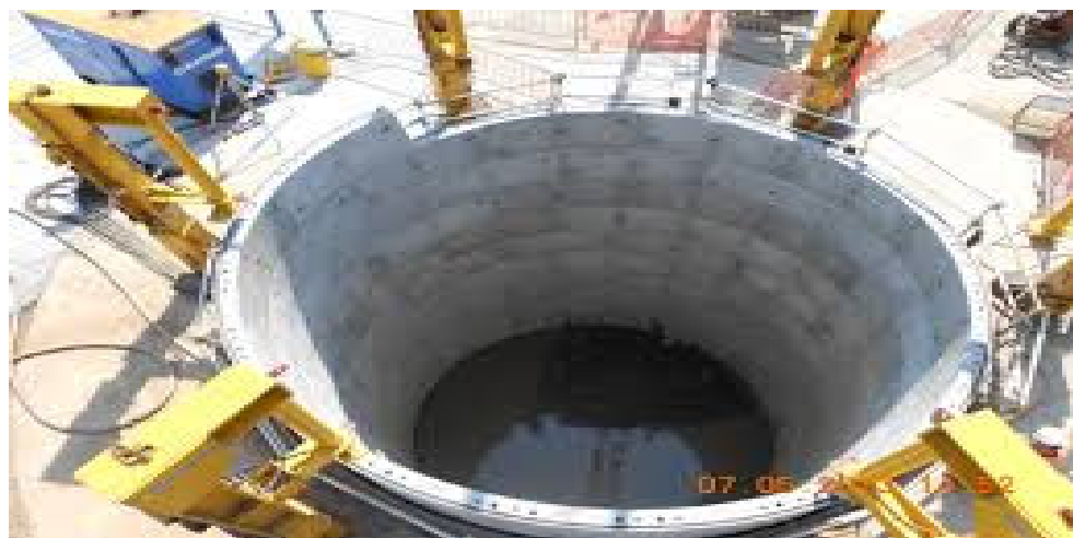
شكل (6-4): محطة من النوع المسمى العمود العميق (Deep shaft)
