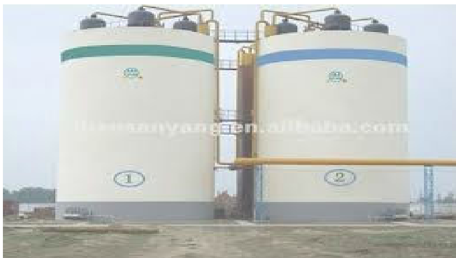
شكل (15-4): مفاعلات حديثة تستخدم للمعالجة البيولوجية اللاهوائية لرواسب مياه المجاري
