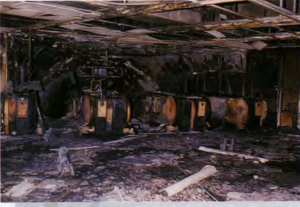
السلالم الكهربائية عند محطة تقاطع الملك الخاصة بقطار الأنفاق بعد حريق عام ١٩٨٧.
